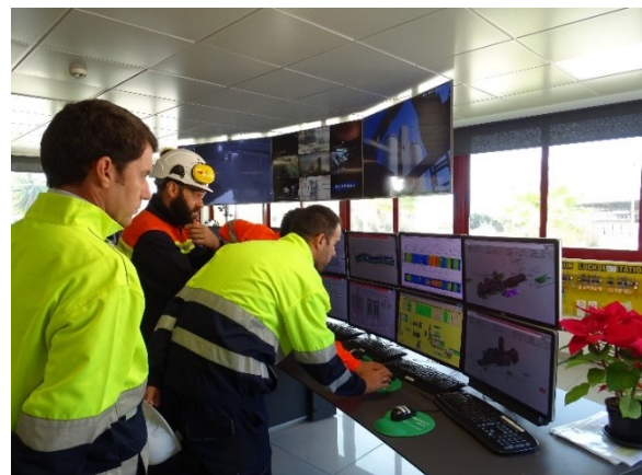
Integración y comunicación de datos del Sistema RKS300 al sistema de control de la planta
